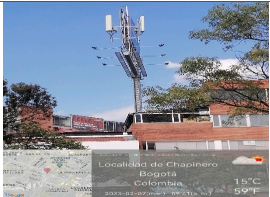
Foto 3. Vista del mástil en buenas condiciones y estable.
